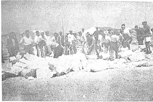
Έργα στην οδό Μανωλάδων με κοινή εργασία Αλικαρνασσιέων στη δεκαετία 1950
